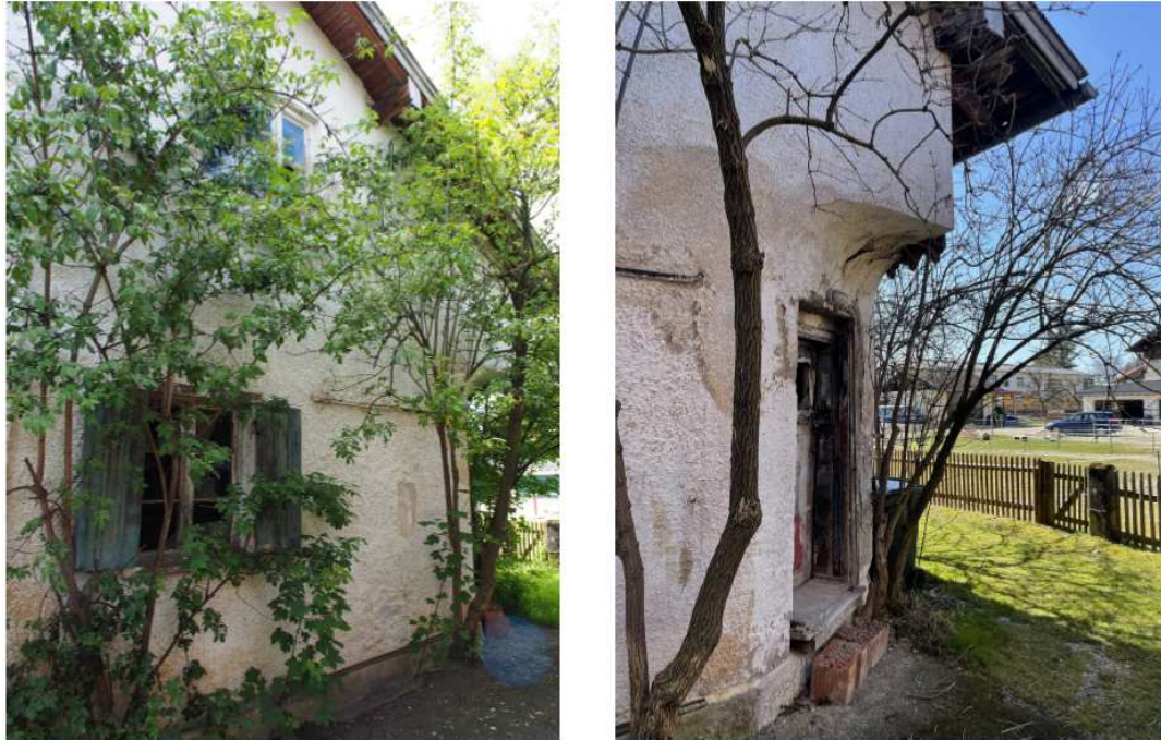
Abb. 4 Nordgiebel und Eingang Hausecke (Quelle: Sunder- Plassmann Architekten)
