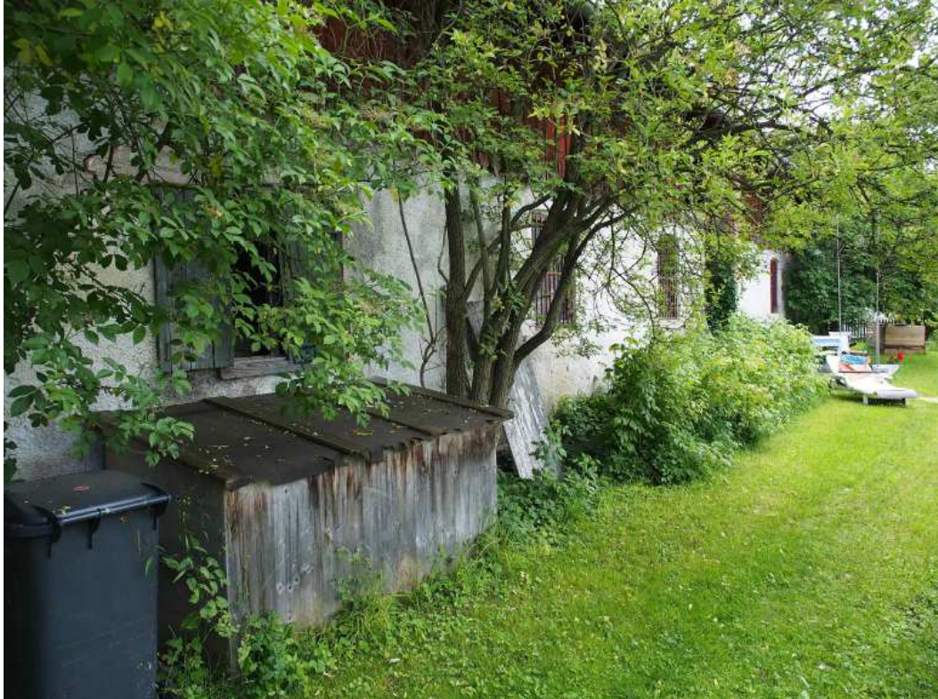
Abb. 2 Blick auf die bestehende Remise im Westen (Quelle: Sunder- Plassmann Architekten)
