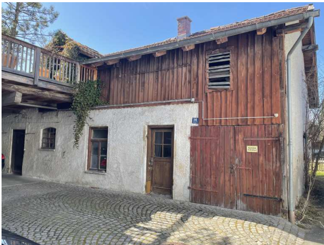
Abb. 3 Remise Ostansicht (Quelle: Sunder- Plassmann Architekten)
