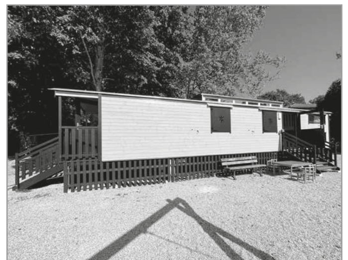
Waldkindergartenwagen - Ansicht von außen
