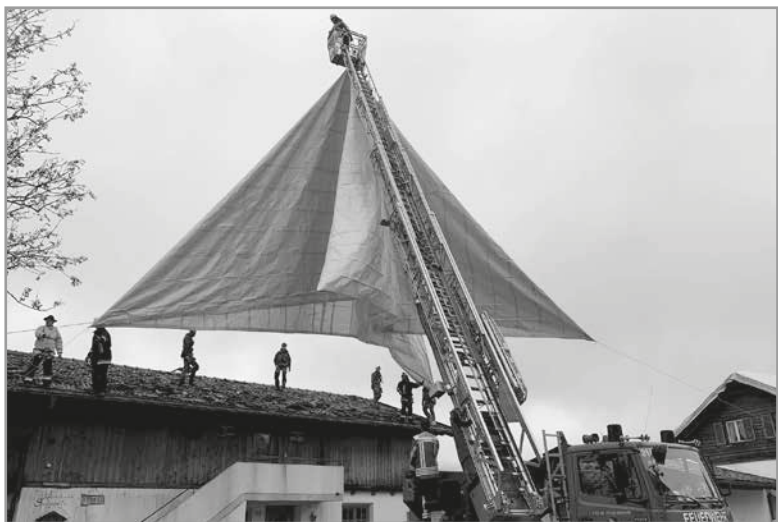
Unzählige Notdächer wurden in den Gemeinden Benediktbeuern und Bad Bayersoien mit Hilfe von Drehleitern und den Feuerwehren aus der Umgebung montiert. Foto: Archiv FFW Seeshaupt
