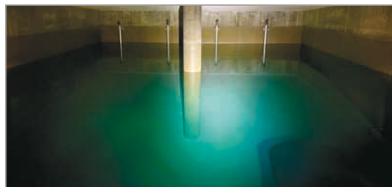
Foto oben: Blick in den neuen Hochbehälter
