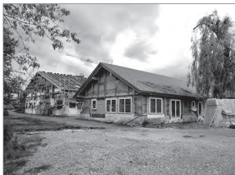
Aktueller Stand des Rohbau
