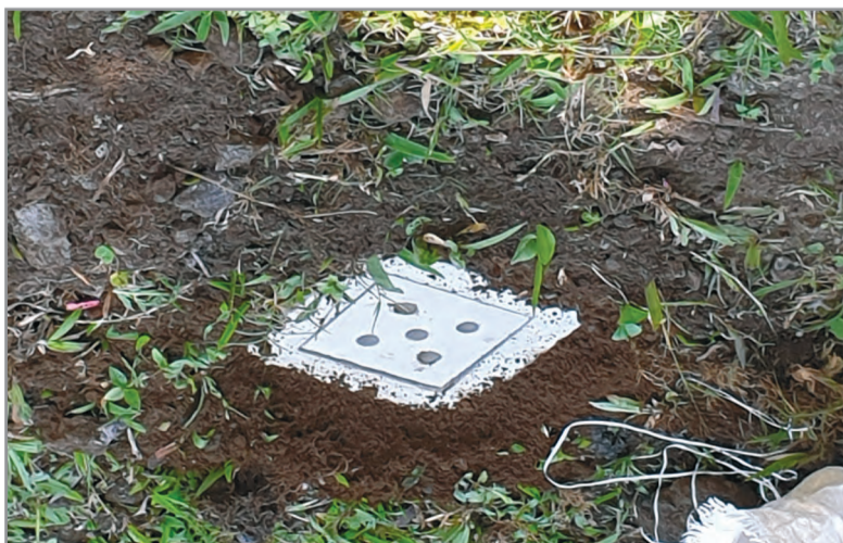
Biopori: Rohre mit zehn Zentimetern Durchmesser werden einen Meter tief im Boden vergraben und mit einem gelochten Deckel verschlossen. Die in das Rohr geworfenen Essensabfälle werden nach drei Monaten zu Kompost.
