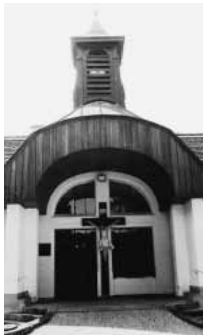
Die Leichenhalle muss renoviert werden.
