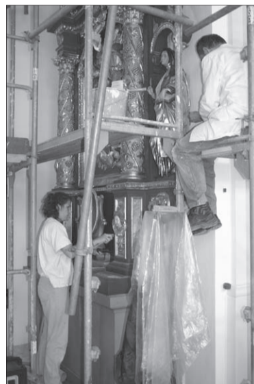
Über Monate war St. Michael eine Baustelle - es hat sich gelohnt.
