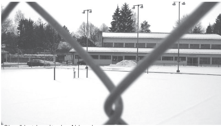
„Oben“ hat bereits der Abbau begonnen...
