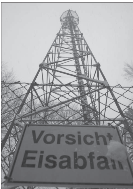
Auch „Vodafone“ sendet bald von hier.
