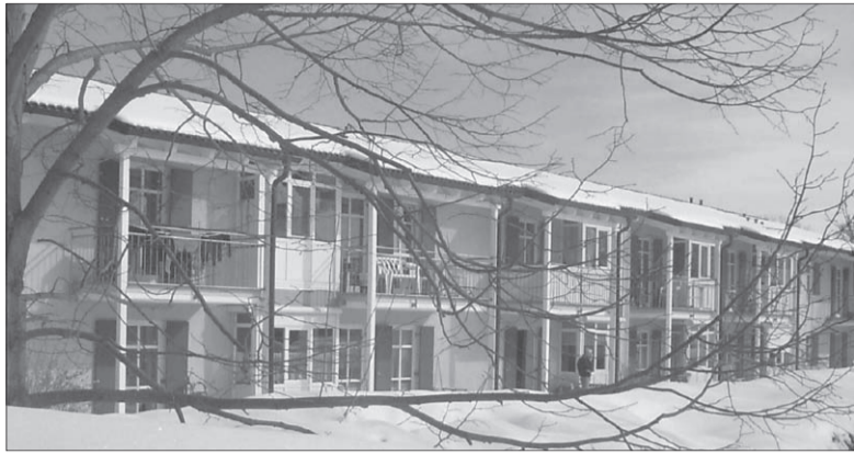
Die Südseite des Daches des Seniorenzentrums erhält Kollektoren.
