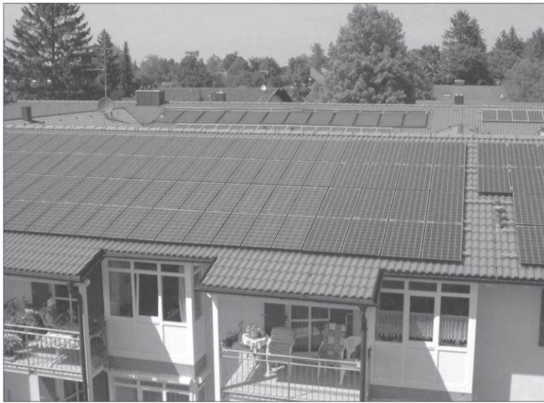
Auf den nach Süden ausgerichteten Dächern sind 220 Kollektoren installiert. Bei der Einweihungsfeier wurde der Anlage gar der kirchliche Segen erteilt. Foto: Ackermann
