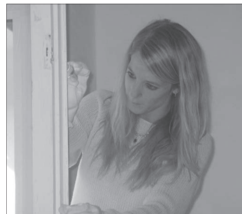
Die Renovierung in Eigenleistung läuft bereits auf Hochtouren - hier ist Alexandra Windisch am Werk.
