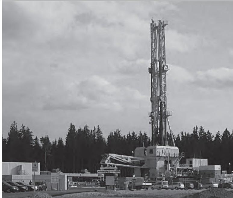
Bohrturm Kirchstockach bei Unterhaching
