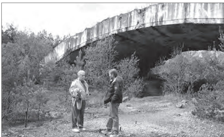
Louis Sneh mit seinem Sohn auf der „Hauptbaustelle“
