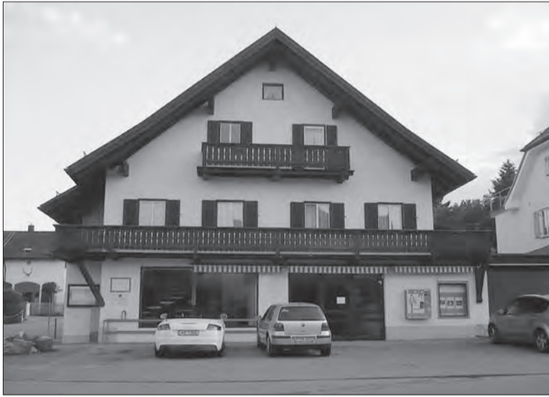
Aus der Biegung der Postkurve war der Blick auf das Ladenschild immer der erste Eindruck von der Seeshaupter Dorfmitte. Seit längerem steht der Laden in der Hauptstraße 16 leer - auf Dauer keine gute Visitenkarte für den Ort. Foto: fm
