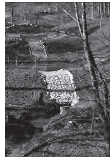
Regenrückhaltebecken, Foto: tl
