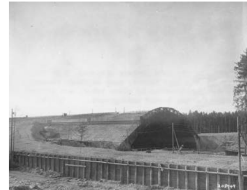
Der Rüstungsbunker im Mühldorfer Hart
