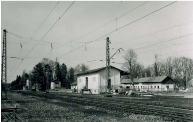
Die Güterhalle mit der Bahnmeisterei 1965. 1968 wurde die Bahnmeisterei (rechts hinten) aufgelöst, 1986 der Güterverkehr eingestellt.
