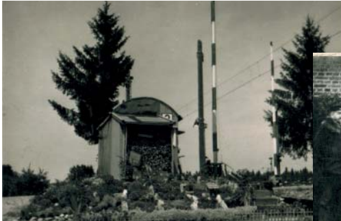
Der „Schrackenposten 3“ wurde 1970 abgerissen, als die Bahnüberführung an der Weilheimer Straße gebaut wurde.
