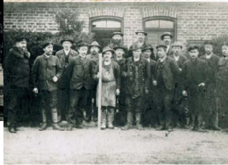
Die Seeshaupt Rotte (links der Rottenführer) im Jahr 1930
