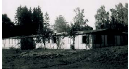
Bau der Baracken 1944
