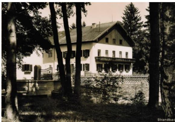
1936: die zum Strandhotel umgebaute Kurklinik
