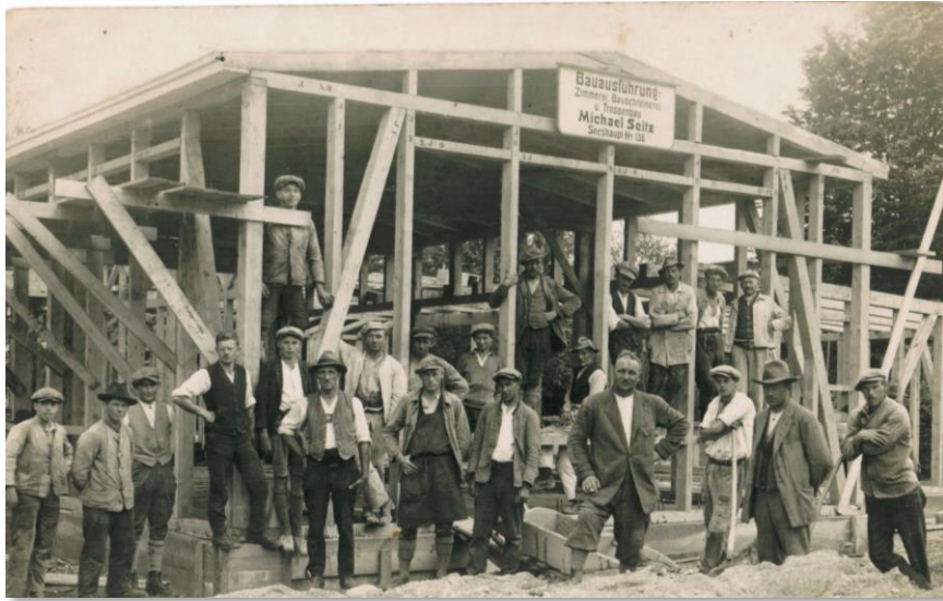
1929: Rohbau der Strandhalle, später Restaurant am See
