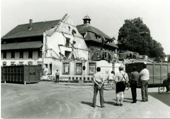
1992: Abriss aller Gebäude mit Ausnahme des Postsaals
