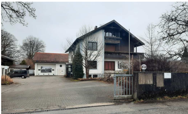
Abb. 10 Wohnhaus Bestand mit Packhalle im Hintergrund (AGL, 2023)
