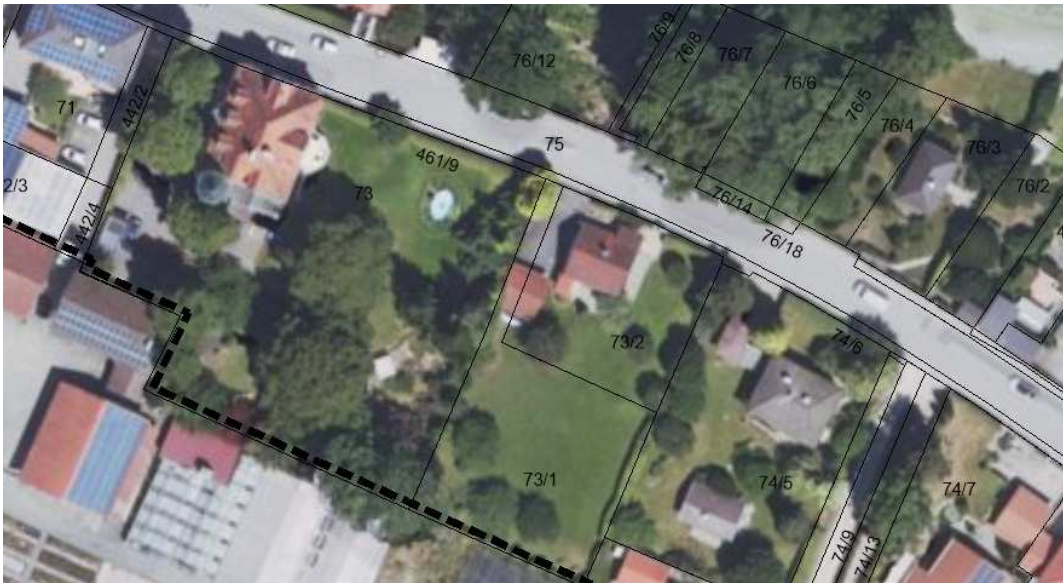
Abb. 8 Direkt nördlich angrenzenden Grundstücke: Fl.Nr. 73 mit Villa „Seeschlösschen“ St. Heinricher- Str. 6 im Westen, Fl.Nr. 74/5: St.-Heinricher Str. 14b Wohngebäude Gartenflächen mit Villencharakter (Quelle: Digitales Orthophoto)
