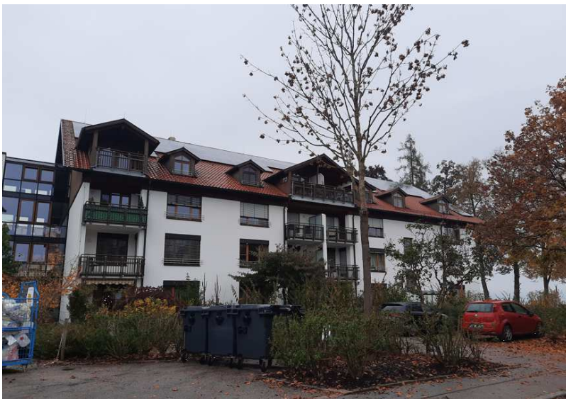
Abb. 6 Blick auf die Seniorenresidenz Richtung Westen (AGL, 2023)
