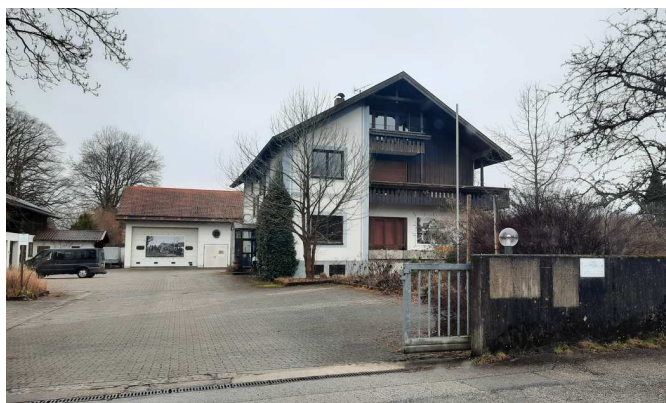
Abb. 10 Wohnhaus Bestand mit Packhalle im Hintergrund (AGL, 2023)
