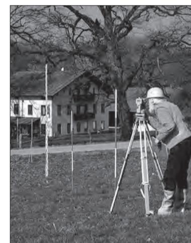
Mit den Vermessungsarbeiten wurde bereits begonnen, Foto: tl
