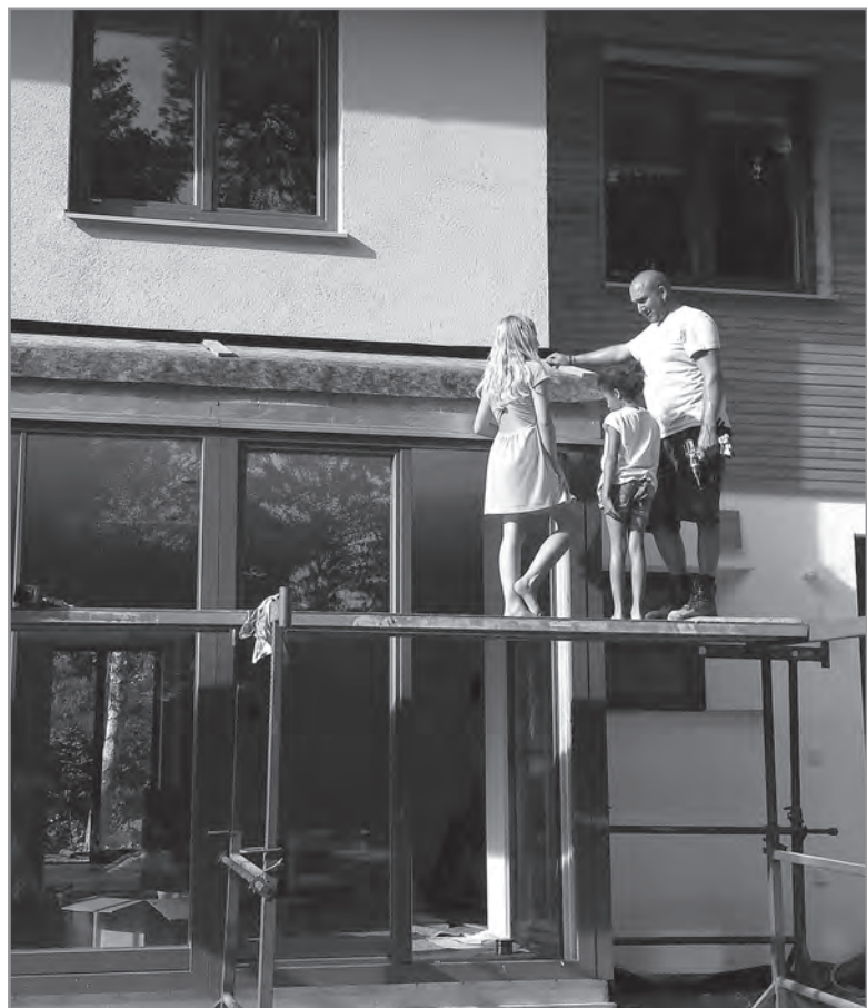
oben: "Was macht'n der da?", das und ähnliches fragten die Kinder sehr oft beim Bau des neuen "Haus südSee".
